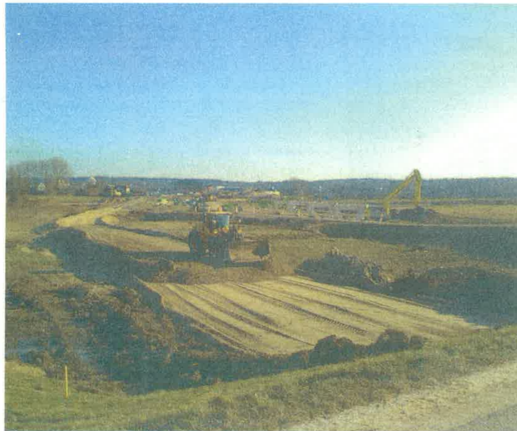
Het Ruimte voor de Rivier-project Nederrijn is aanbesteed in BVP-vorm. Hierdoor heeft het project al een jaar tijdswinst geboekt. Om de rivier meer ruimte te geven gaat in De Tollewaard de schop de grond in: een groot deel van de zomerkade wordt afgegraven waardoor de uiterwaard in de nieuwe situatie eerder onder water staat (gemiddeld 10 dagen per jaar). De brug die nu in aanbouw is zorgt ervoor dat de bedrijven en de woningen dan toch bereikbaar zijn. Eind 2013 is de brug klaar. Foto: Rijkswaterstaat
